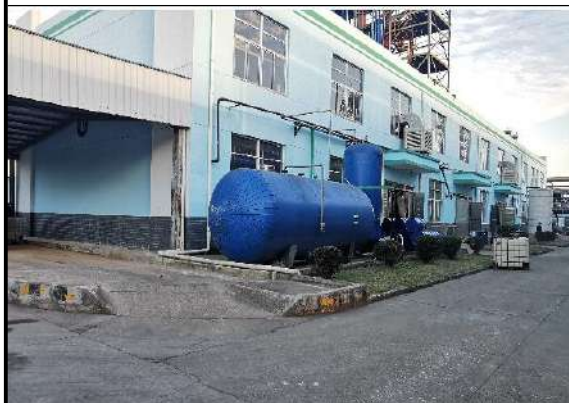
污水预处理车间 (H5)
