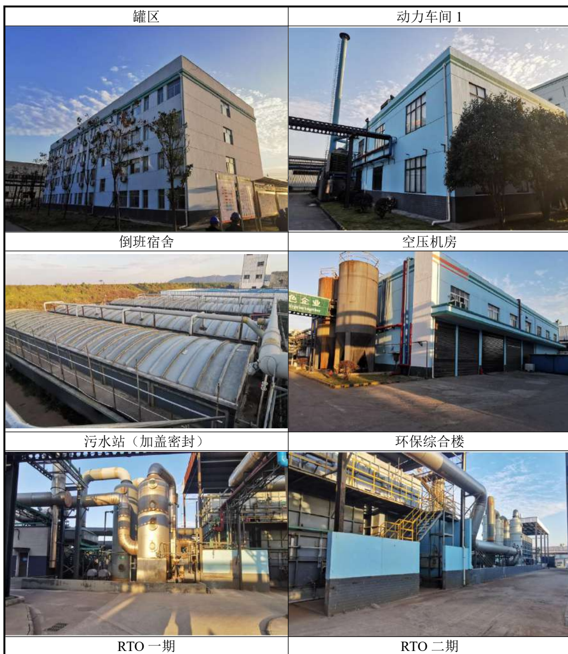
图 3.1.1-1 已建项目厂内照片
